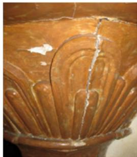
Kanzel – diese ist komplett vom Mauerwerk abgelöst und es besteht die Gefahr des Einsturzes.
