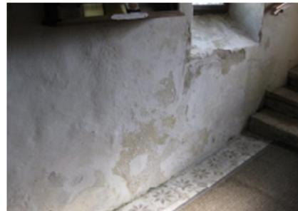
Mauerwerk- speziell im Vorraum und im kompletten hinteren Bereich ist die Mauer feucht und in einem desolaten Zustand.
