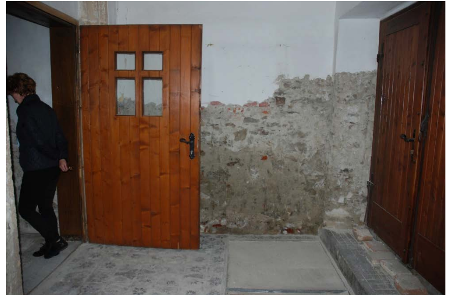
Vorraum hinten, extrem nasse Stellen
