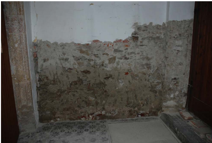
Vorraum hinten, extrem nasse Stellen
