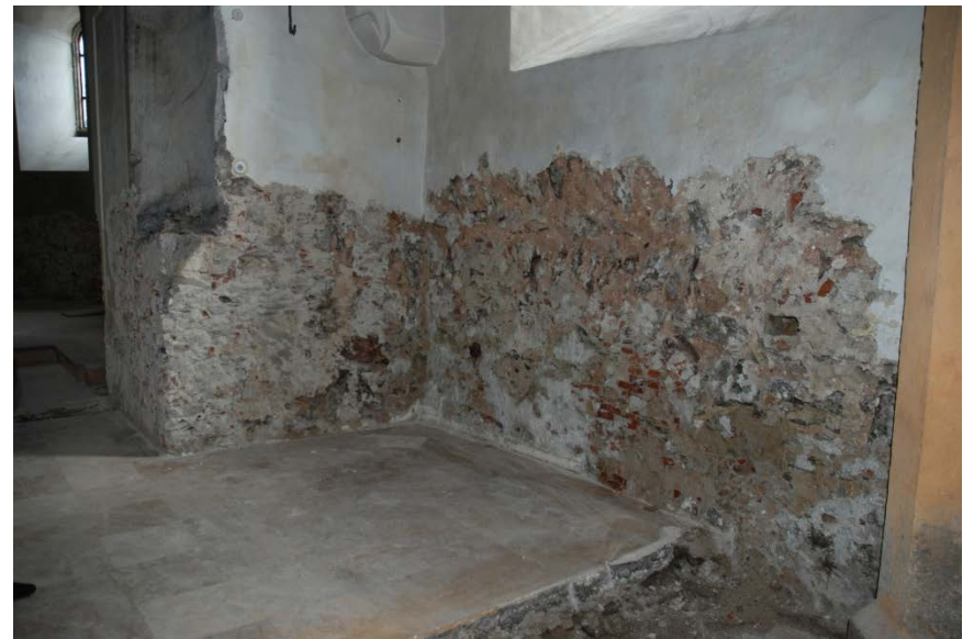
Vorraum hinten, extrem nasse Stellen
