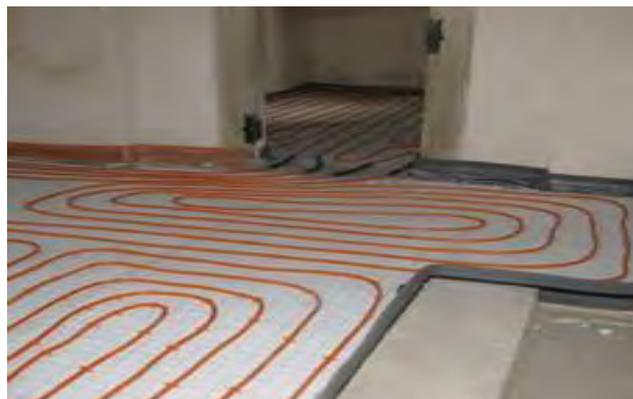
Der Installateur hat die Fußbodenheizung im kompletten Altarbereich, der Sakristei und im neuen Beichtzimmer fertiggestellt. Die Elektroleitungen wurden alle erneuert und ein neuer Verteiler- und Schalterkasten eingebaut. Der Elektriker ist bereits dabei, einige Schalter und Steckdosen zu montieren.
